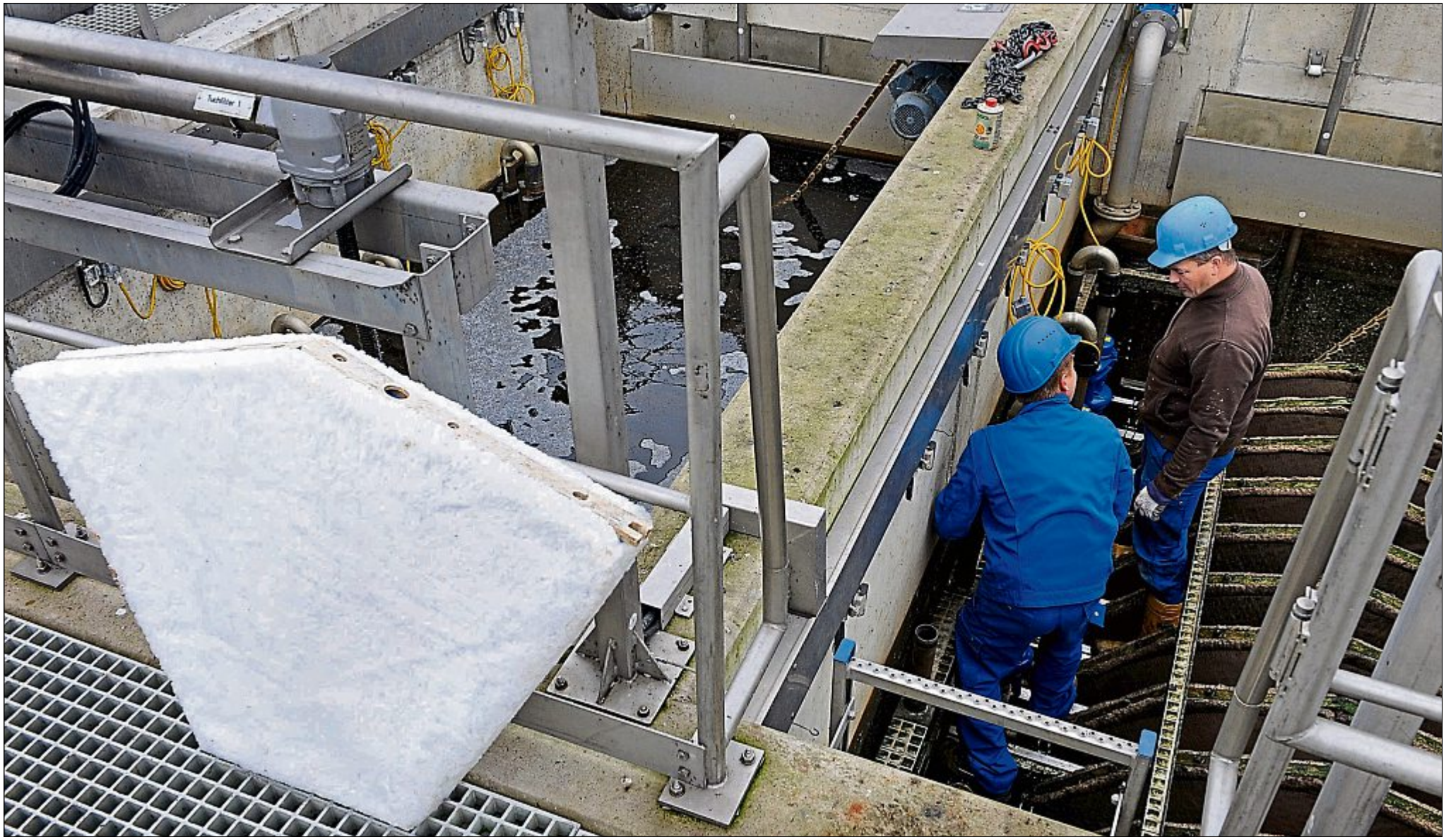
Zwei Mitarbeiter einer Kläranlage installieren ein neues, unbenutztes Filterelement zur Absorption von Mikroplastik aus dem Abwasser in ein Klärbecken.
